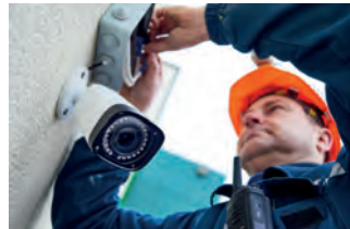
Gebäude- und Grundstücksüberwachung
