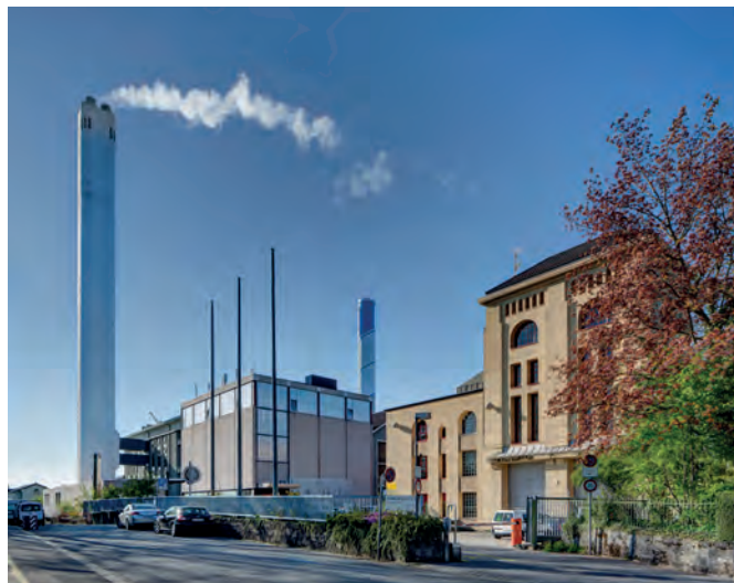
L'usine de Pierre-de-Plan fait partie des usines thermiques les plus importantes des SiL (Services industriels Lausanne). Environ 560 collaborateurs approvisionnent plus de 250.000 personnes et entreprises de la région.
